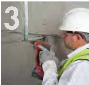
Fixing Knauf Angle Section to upper Knauf 'C' Channel.
