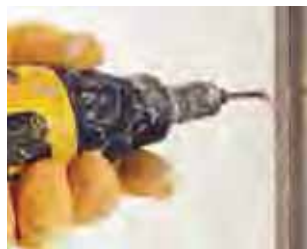
Fixing Knauf Aquapanel using Knauf Aquapanel Maxi Screws.
