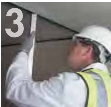
3 Twisting Knauf 'C' Stud into position.
