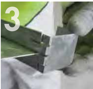
A Knauf Staggered Stud Clip is fixed to the Knauf 'I' Stud.
